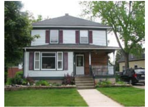
430 N. Michigan St. American Foursquare
