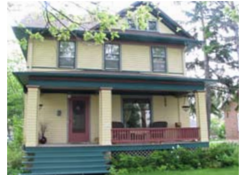
220 N. Michigan St. American Foursquare
