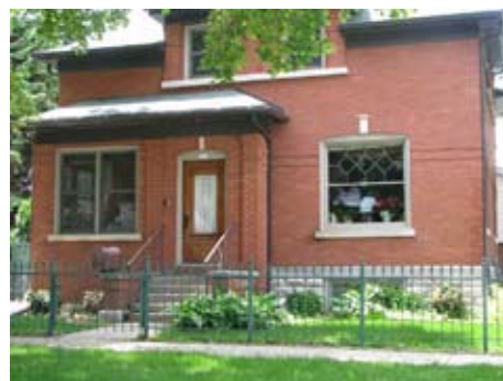
133 N. Superior St. American Foursquare
